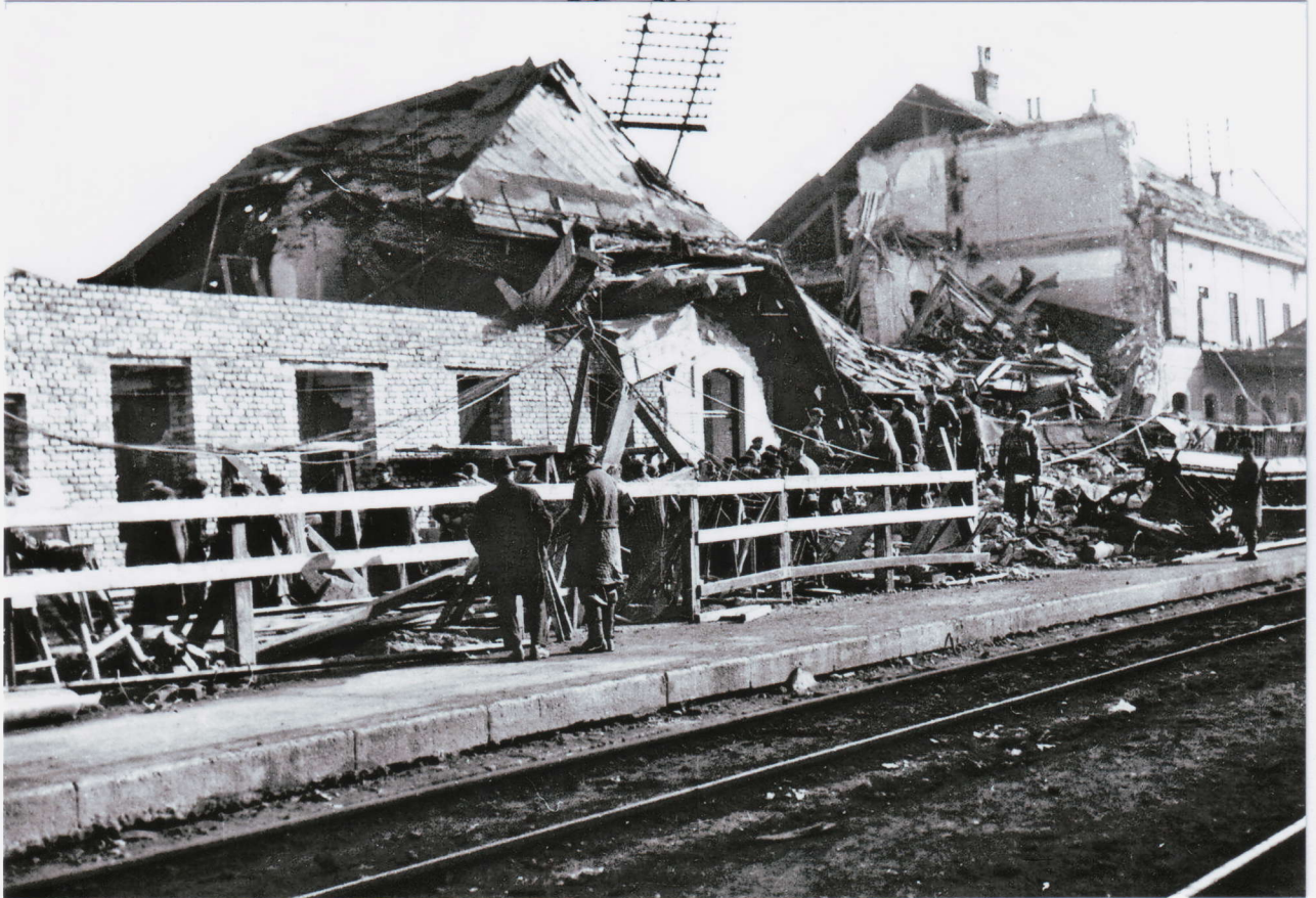
o.: März 1945; Vollkommen zerstörtes „Aufnahmsgebäude“ des Bahnhofes.
