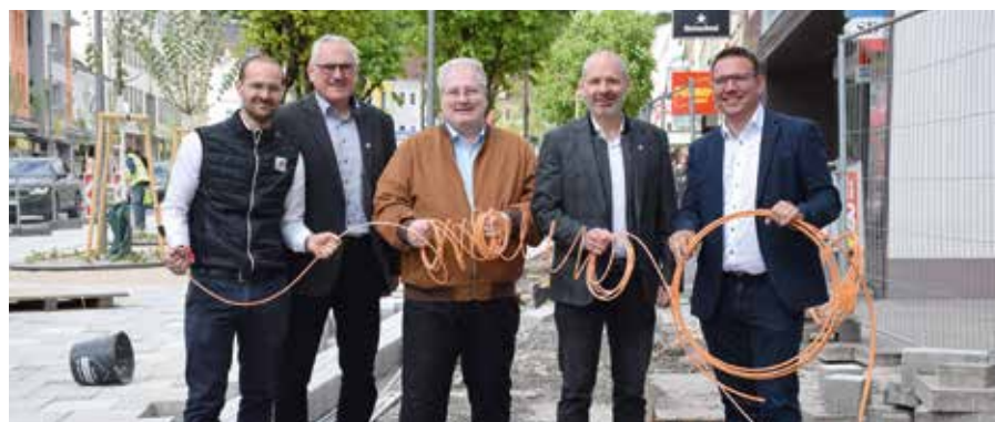
Philipp Röhm (A1), Paul Galuska (A1), Digitalisierungsgemeinderat Peter Fuhs, Michael Seitlinger (A1) und Bürgermeister Christian Haberhauer am Hauptplatz, wo im Zuge der Neugestaltung Glasfaserleitungen verlegt werden
